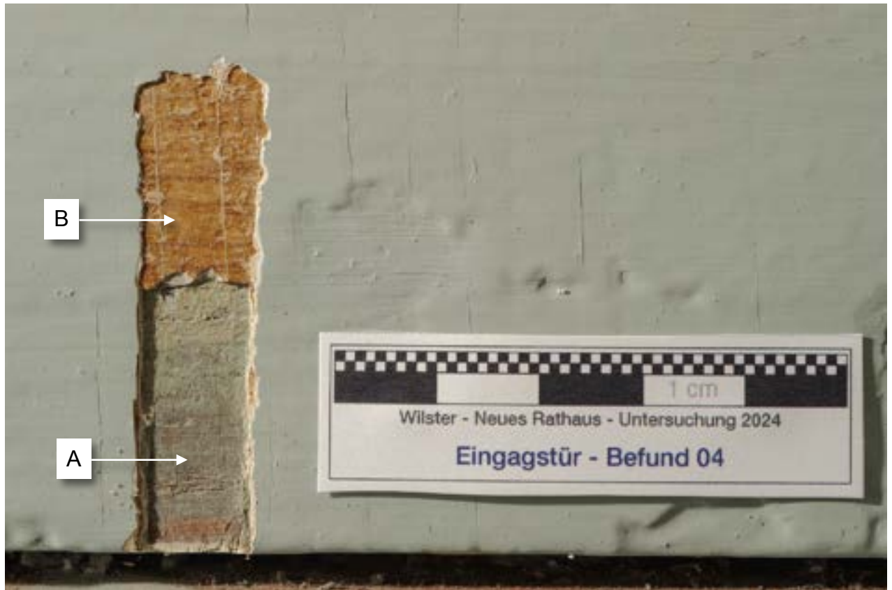
Befund 04 - Außentür - Oberlicht - Aufnahme: Q1000301
